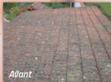
Exemple de nettoyage et hydrofugation sur toiture terre cuite
